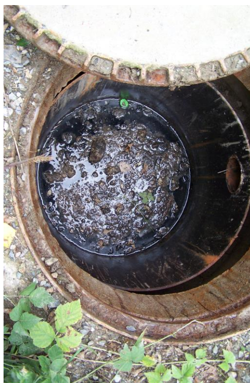
Photo n°7 : Intérieur de la fosse
