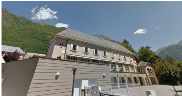
Toit de l'école
