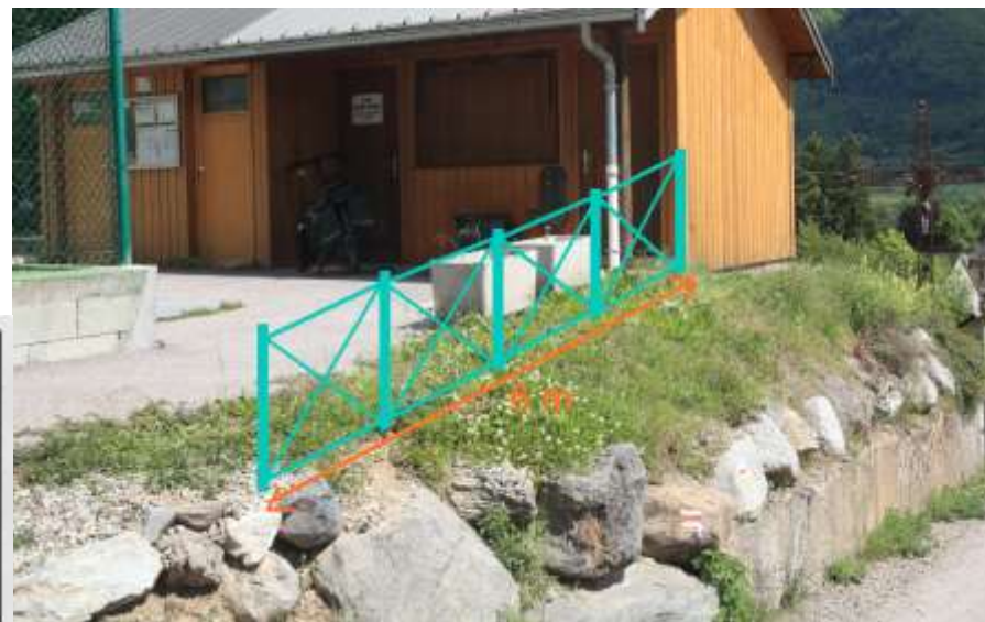
Sécurisation des abords du chalet de tennis
