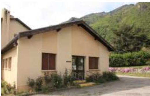
Réparer la fuite au dessus de la Bibliothèque (Pascal)
