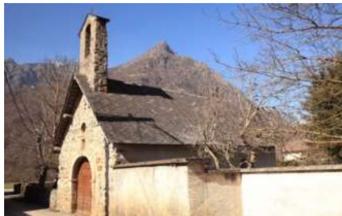
Réparation du plafond de la chapelle de La Roche – Terminé - Entreprise Sonzogni Père et fils à Mens - DOB : 6 000€
