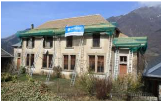
Réparation du toit de l'ancienne école des Angelas 33 000 € (Entreprise Sonzogni)
