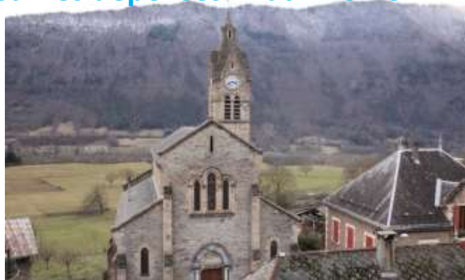
Entretien des 2 clochers des églises Devis de la Charpenterie : 28 440 €
