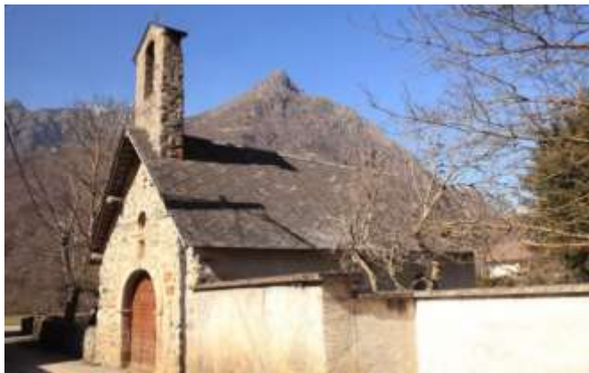
Réparation du plafond de la chapelle de La Roche – Terminé - Entreprise Sonzogni Père et fils à Mens - 6 000€
