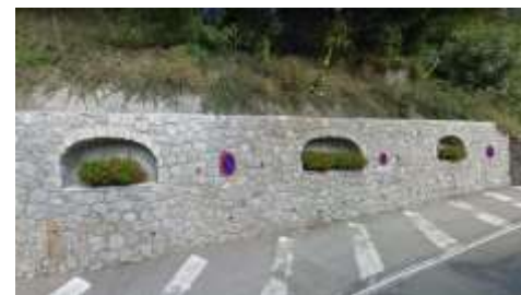
Rue Principale (Chemin du Cimetière) Interdit de stationner x 3
