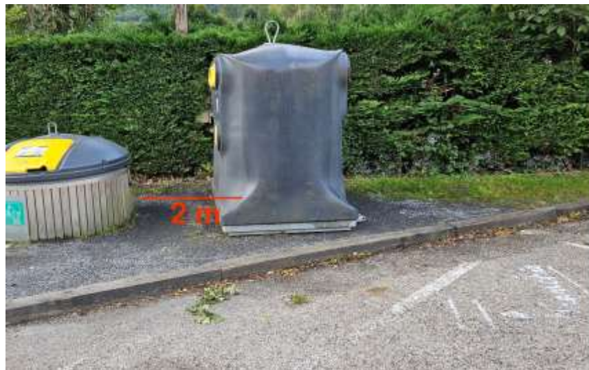
Aujourd'hui, la colonne est mal placée
