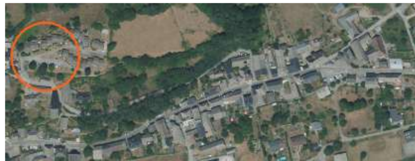
Les Nicolaux - Sous Belle Roche : repandre le goudron
