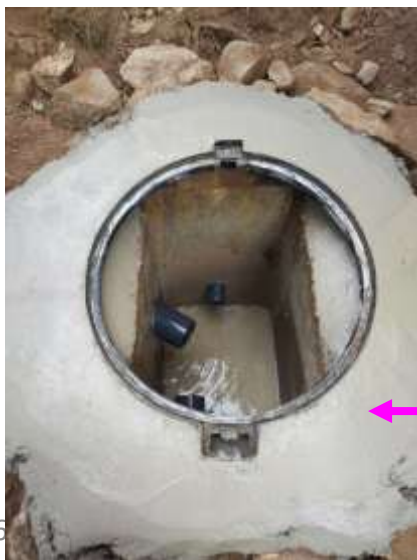
Etanchéité du captage Pré Blanchon
