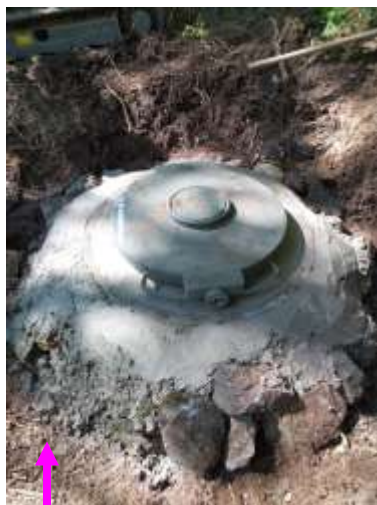
Etanchéité du captage Pré Blanchon
